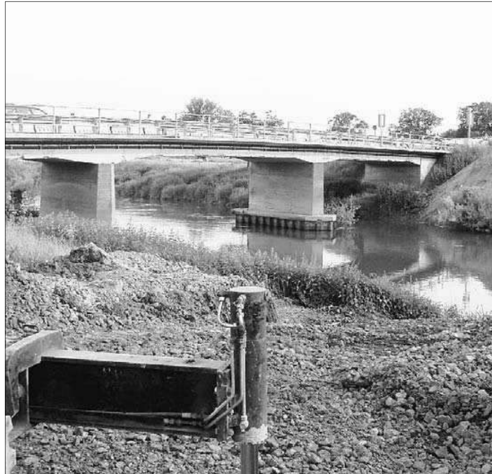
Sechs Jahrzehnte lang hat sie ihren Dienst getan, doch bald schlägt ihre letzte Stunde: Die alte Lippebrücke in Lippborg wird durch ein neues, breiteres Bauwerk abgelöst. Ein Brückenfest ist für den 17. Juni 2006 in Planung. Dann soll der neue Bau auf den Namen Kardinal von Galen getauft werden. Bild: Stengel
