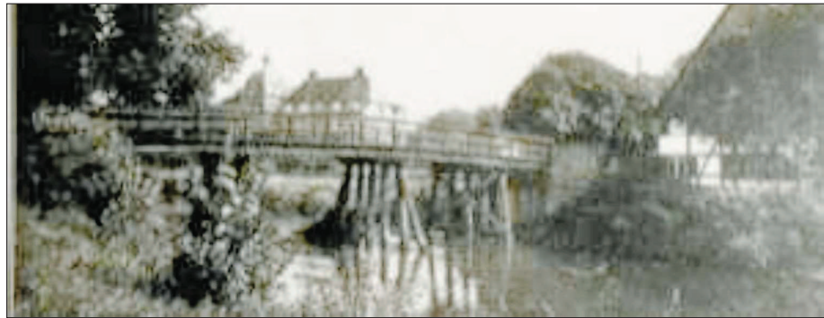
Die alte Holzbrücke über die Lippe tat bis 1925 ihren Dienst. Da sie schwere Lasten nicht tragen konnte, wurde sie durch eine neue aus Eisenbeton ersetzt.
