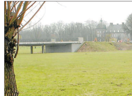
Im Jahr 2007 wurde die neue Lippebrücke zwischen Herzfeld und Hovestadt fertig gestellt.
